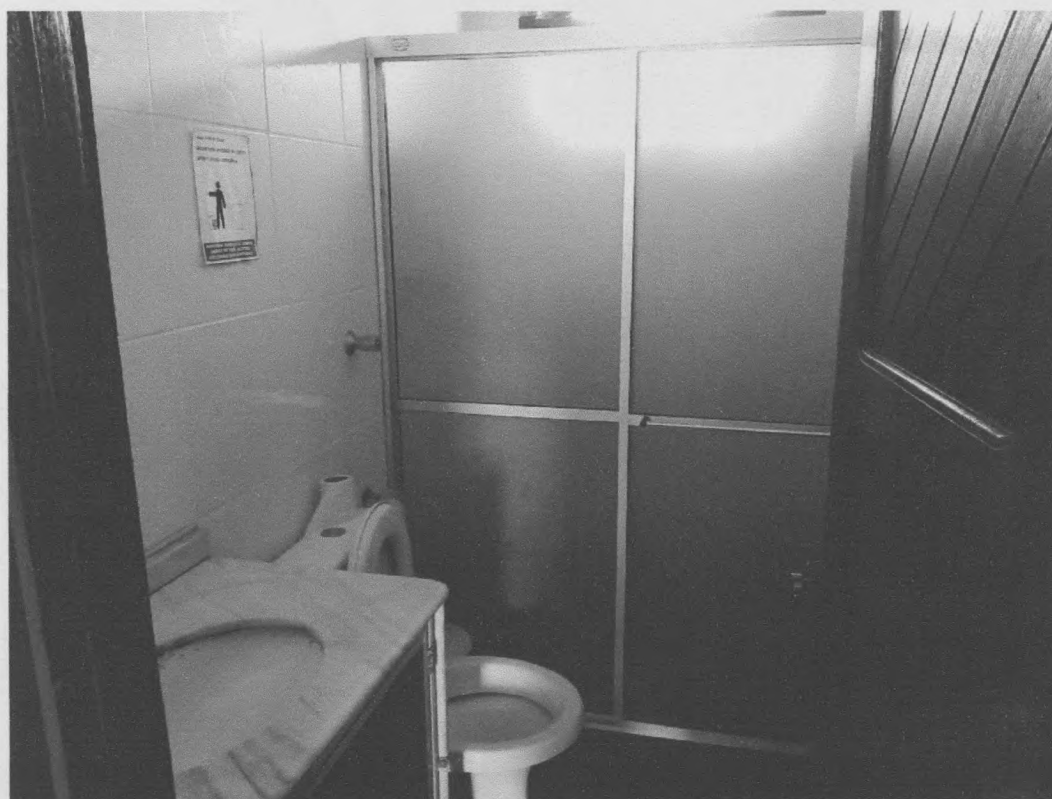
Imagem 03 – Um dos banheiros do imóvel.
