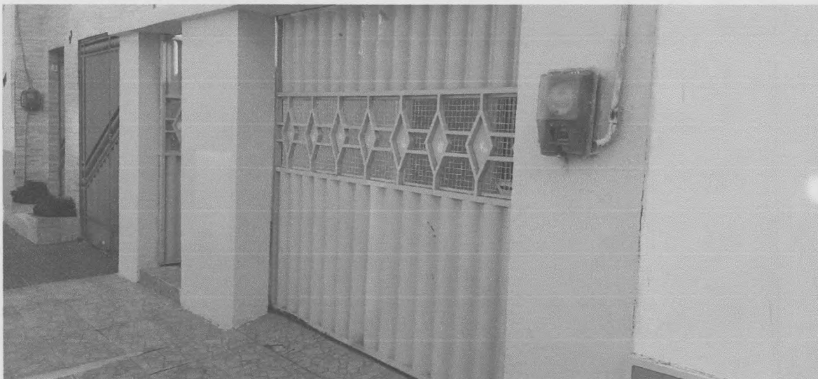
Imagem 01 – Fachada externa do imóvel.
