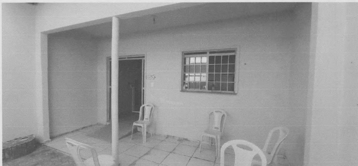
Imagem 02 – Entrada do imóvel.
