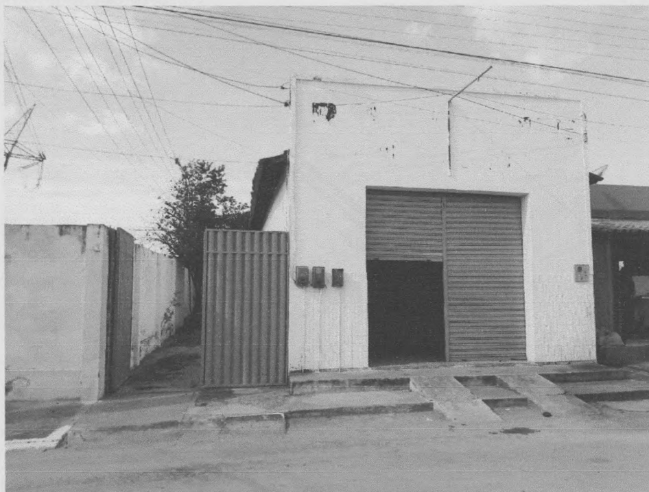
Imagem 01 – Fachada externa do imóvel.
