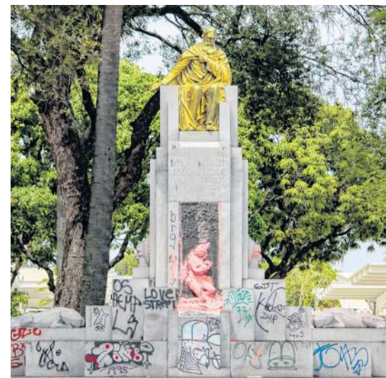
PICHAÇÕES e desgastes na obra
